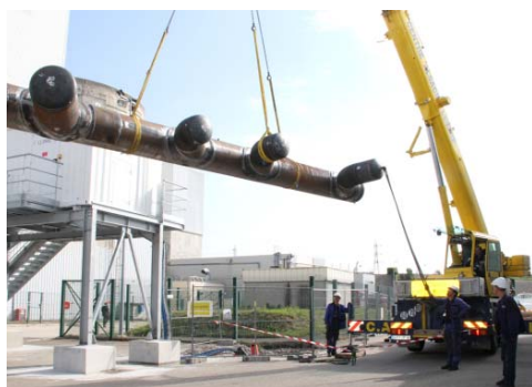
Tronçon de la tuyauterie livré sur le site
