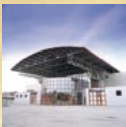
■ Gestion technique des bâtiments
