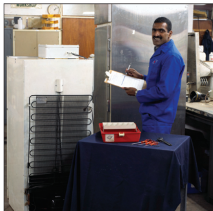
Technicien vérifiant un réfrigérateur pour banque de sang. Vue arrière de l'appareil montrant le compresseur, le condenseur et l'arrière du régulateur/alarme de température.
