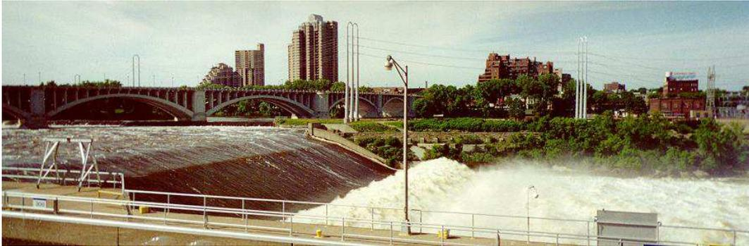
**Figure 5.42** : ressaut hydraulique stationnaire sur le Mississippi au pied du seuil du Saint-Falls Laboratory de Minneapolis (États-Unis). Source : [www.thefullwiki.org/Hydraulic\\_jump](http://www.thefullwiki.org/Hydraulic_jump).
