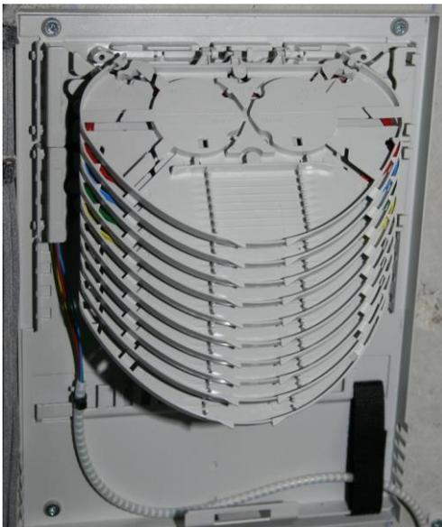
**PBO - Terminologie FTTH** - Point de Branchement Optique - Appelé aussi PBE (Point de Branchement Etage) - Boîtier dans lequel sont raccordé(s) le ou les câbles en fibre optique venant du point de mutualisation et les câbles en fibre optique du raccordement client.
