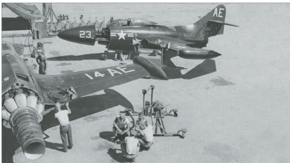
Entretien d'un J42 sur un Panther en Corée en 1951.
